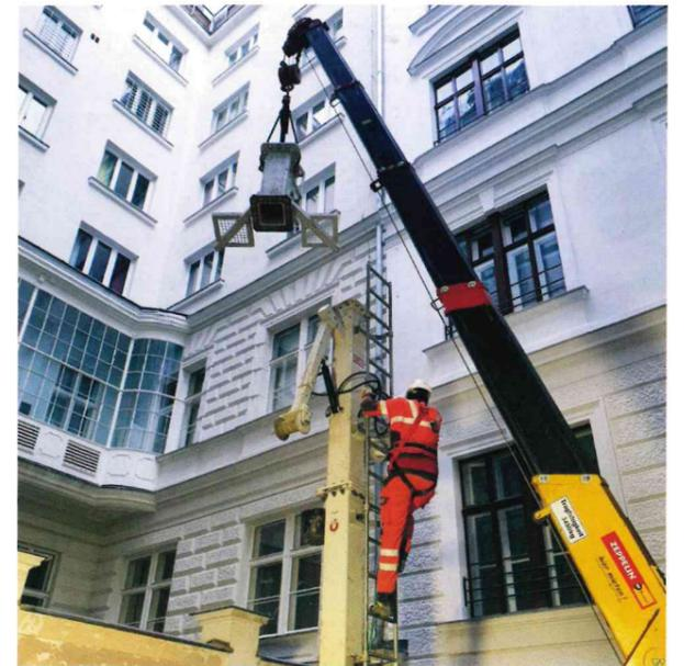
Abb. 2 Aufbau des Bohrturms (Mastmontage) in beengten Verhältnissen
